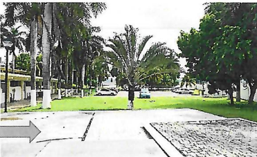
F1: Fachada principal
